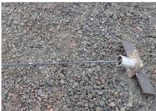
Figur 30 Elektrod-kabeln förankrades i botten på KC-pelaren med hjälp av FOPS-vinge vid försöken på Västlänken (Foto: Mikael Lumetzberger).
